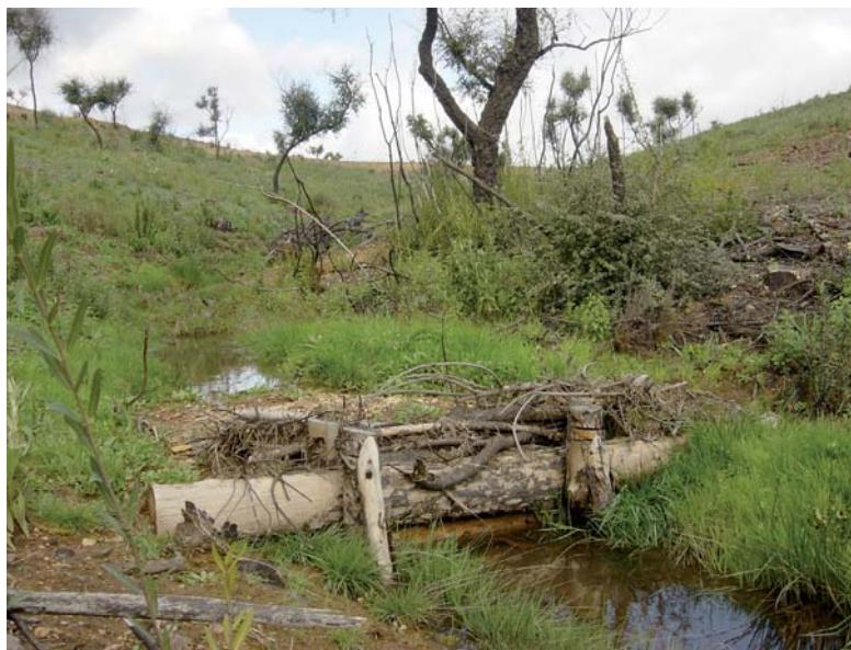
*Correcta construcción de albarrada en un arroyo afectado por un incendio. En la imagen puede observarse los sedimentos retenidos por la estructura*
